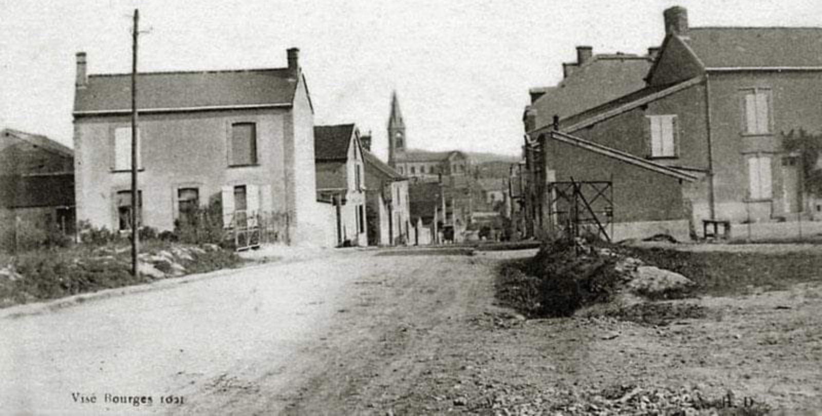
1 - BOUZY (Marne) — Vue Générale (coté sud)
